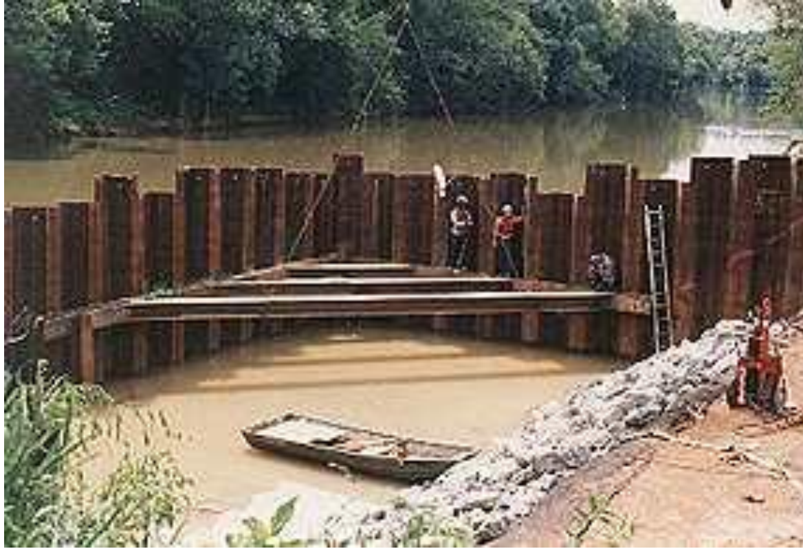
Palplanş kazık duvar
