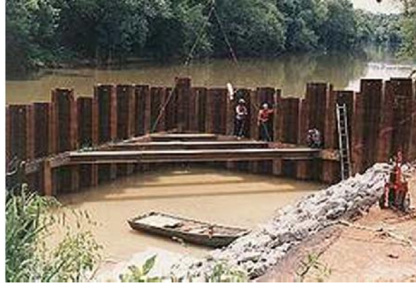
Palplanş kazık duvar
