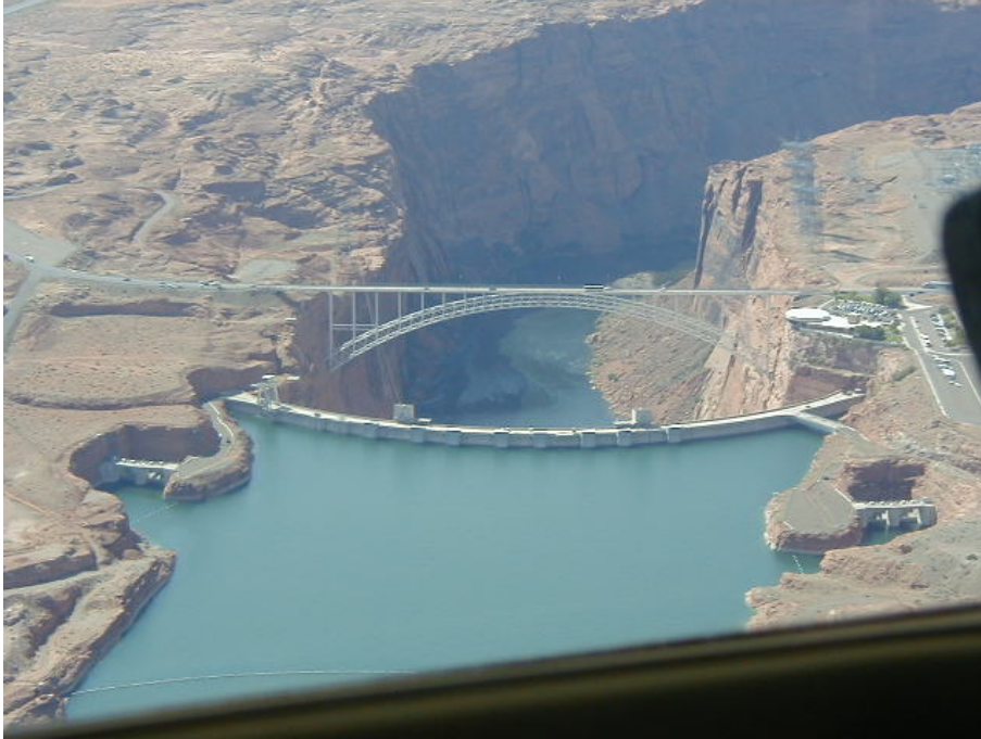
Kemerli ağırlık baraj
