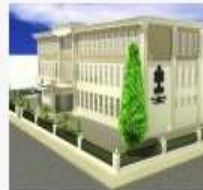
Dış Cephe Tasarımları
