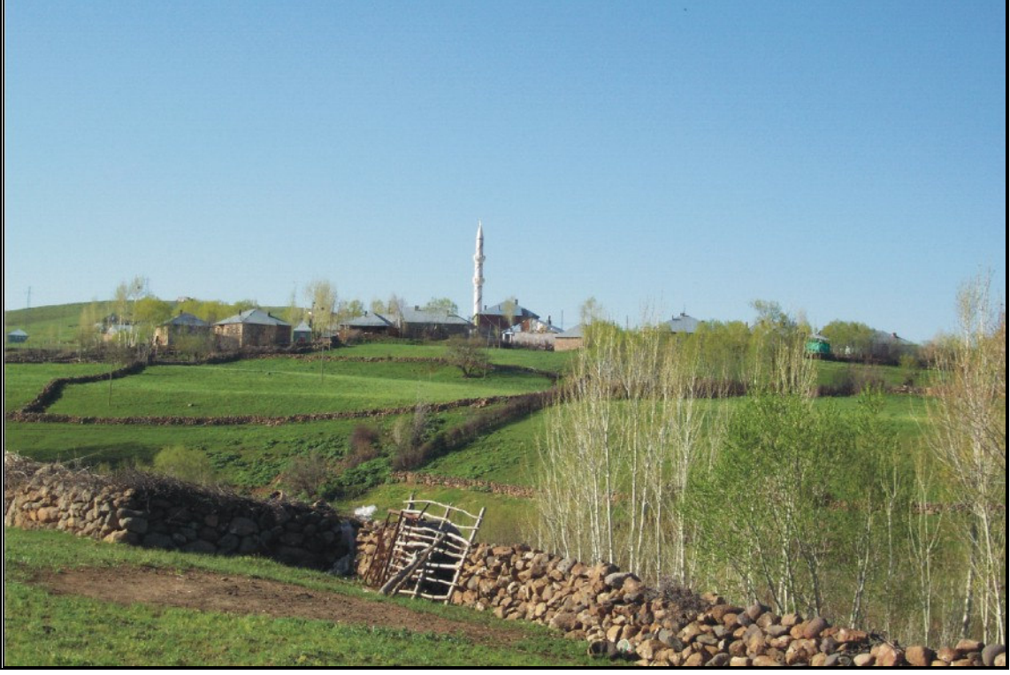
Şekil 29. Cami binası hafif hasar görmesine rağmen hiç hasar görmeyen Balıklıçay Camisi'nin çift şerefeli minaresi.
