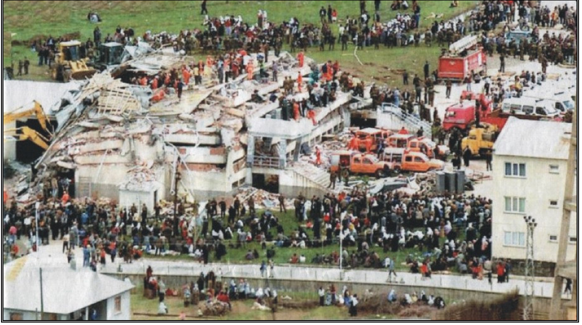
Şekil 25. Çeltiksuyu Yatılı İlköğretim Bölge Okulu pansiyonunun deprem sonrası kurtarma çalışmaları sırasındaki görünümü. ( Akşam Gazetesi )
