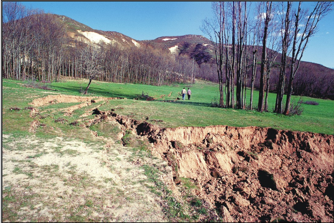
Şekil 16. Hanoçayırı Mevkiinde oluşan heyelanın taç kısmı ve yüzey kırığının KD'ya doğru devam eden kesimi.
