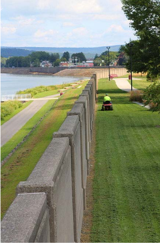
ABD'de inşaa edilmiş bir taşkın duvarı.
